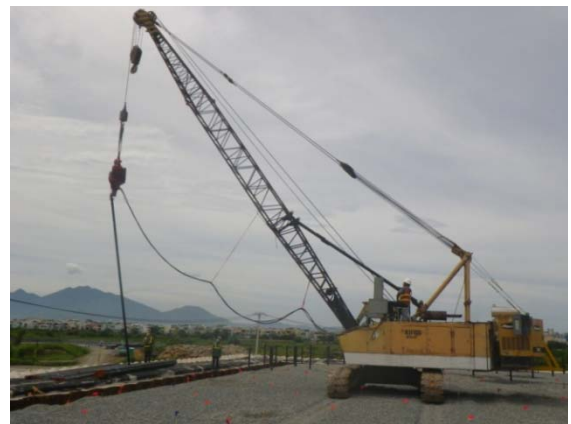
Vận chuyển thiết bị hệ thống xử lý lên trên nóc móng xử lý (Ảnh: CDM Smith)
