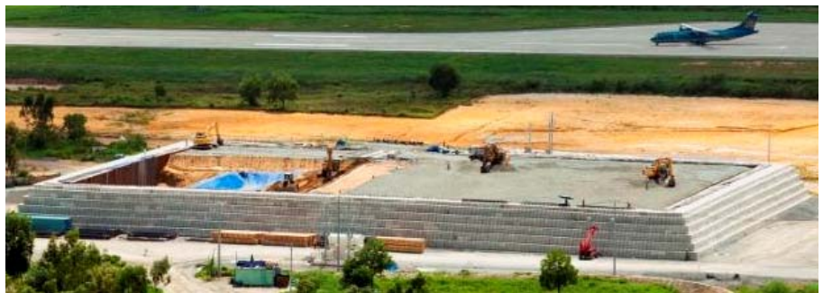
Kết cấu móng hoàn tất, đã chất đầy 55 phần trăm (Ảnh: Tetra Tech)
