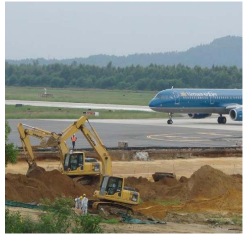
Đào xúc đất phía bắc đường chạy của Sân bay Đà Nẵng (Ảnh: Tetra Tech)
